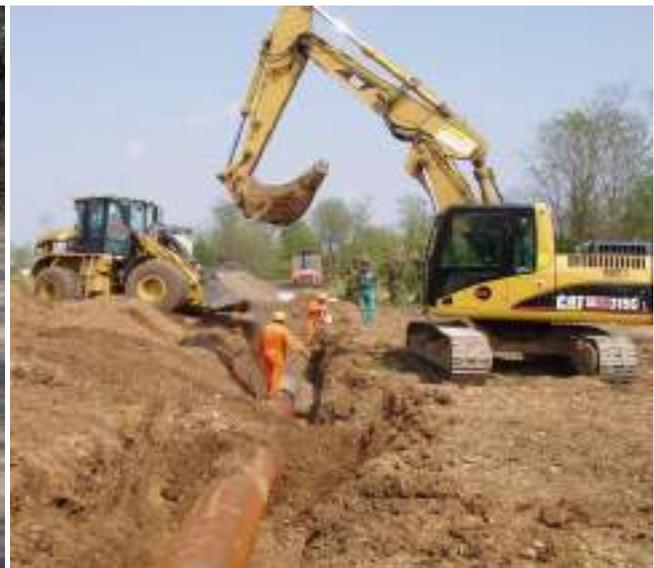
IMMAGINI D'ESEMPIO DI UN'ANALOGA POSA DELLE CONDOTTE E DEI MANUFATTI DI ADDUZIONE E DISTRIBUZIONE (ADIBITI ALL'IRRIGAZIONE A PIOGGIA), PRESSO VILLACACCIA - CANTIERE
